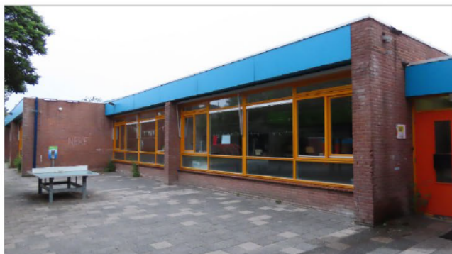
Figuur B2. Arnoldus van Os Zuidplein. Het hogere gebouw is de gymzaal. Er bevinden zich open stootvoegen onder de dakranden.
