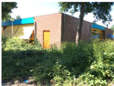
foto 1 - ter plaatse van peilbuis 01
