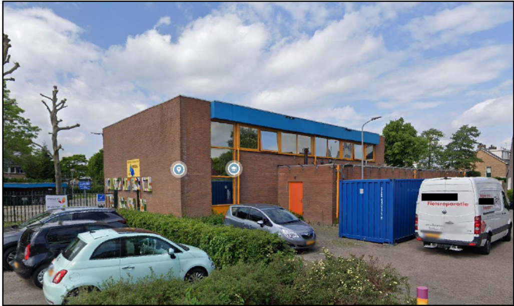
Impressie huidige situatie, aanzicht school vanuit het zuidoosten (bron: Google Maps).
