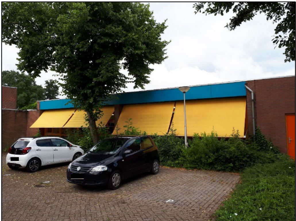
Voorbeeld van de aanwezige zonnewering bij de basisschool.
