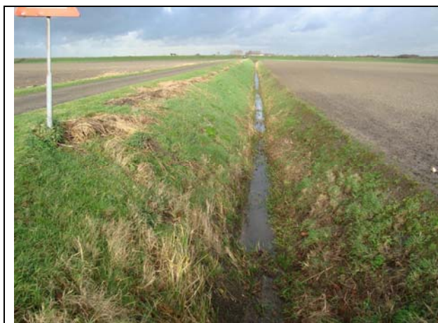
Foto: wegberm langs Middelweg richting noord
