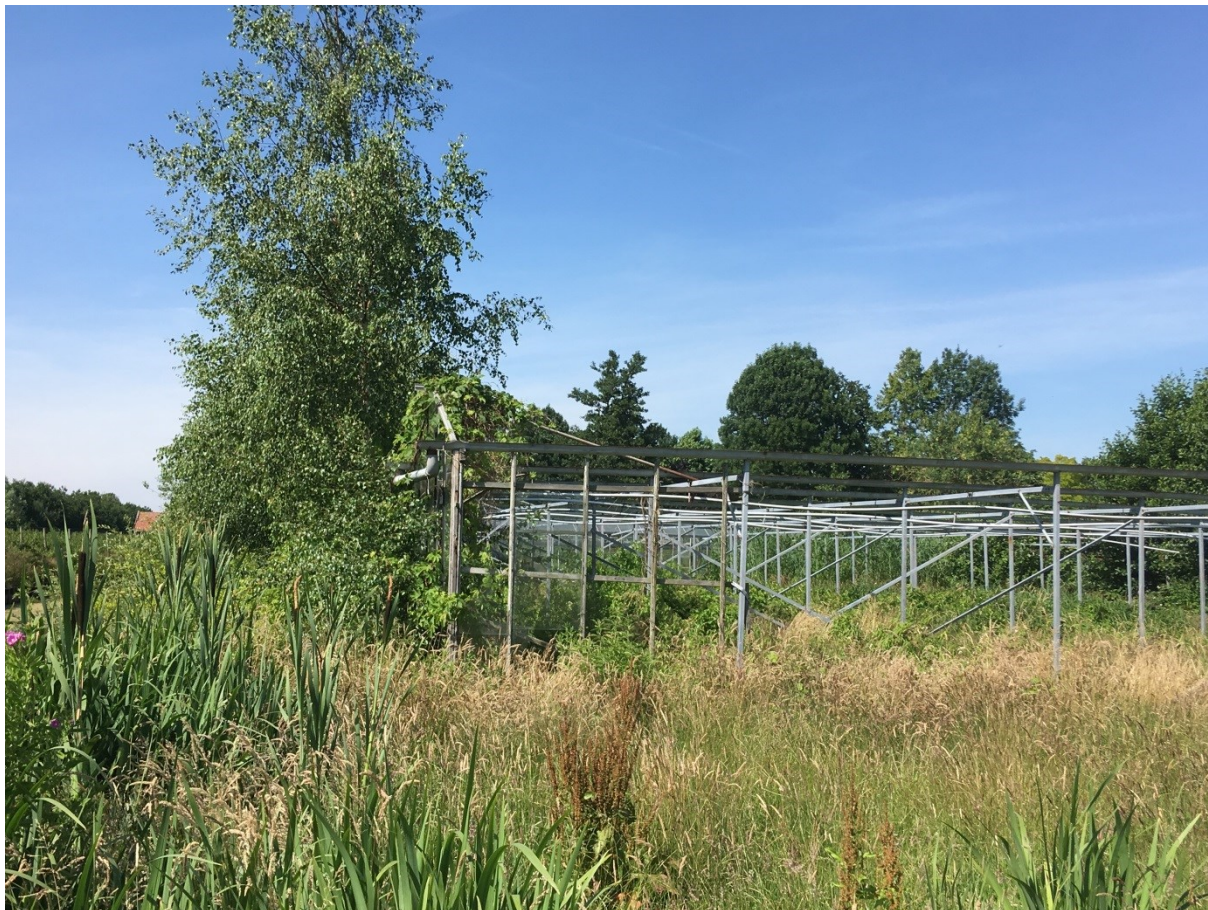
Figuur x.x: het terrein dat zal worden opgeruimd met de nog niet verwijderde delen van de kassen en de verwilderende vegetatie erin en eromheen.
