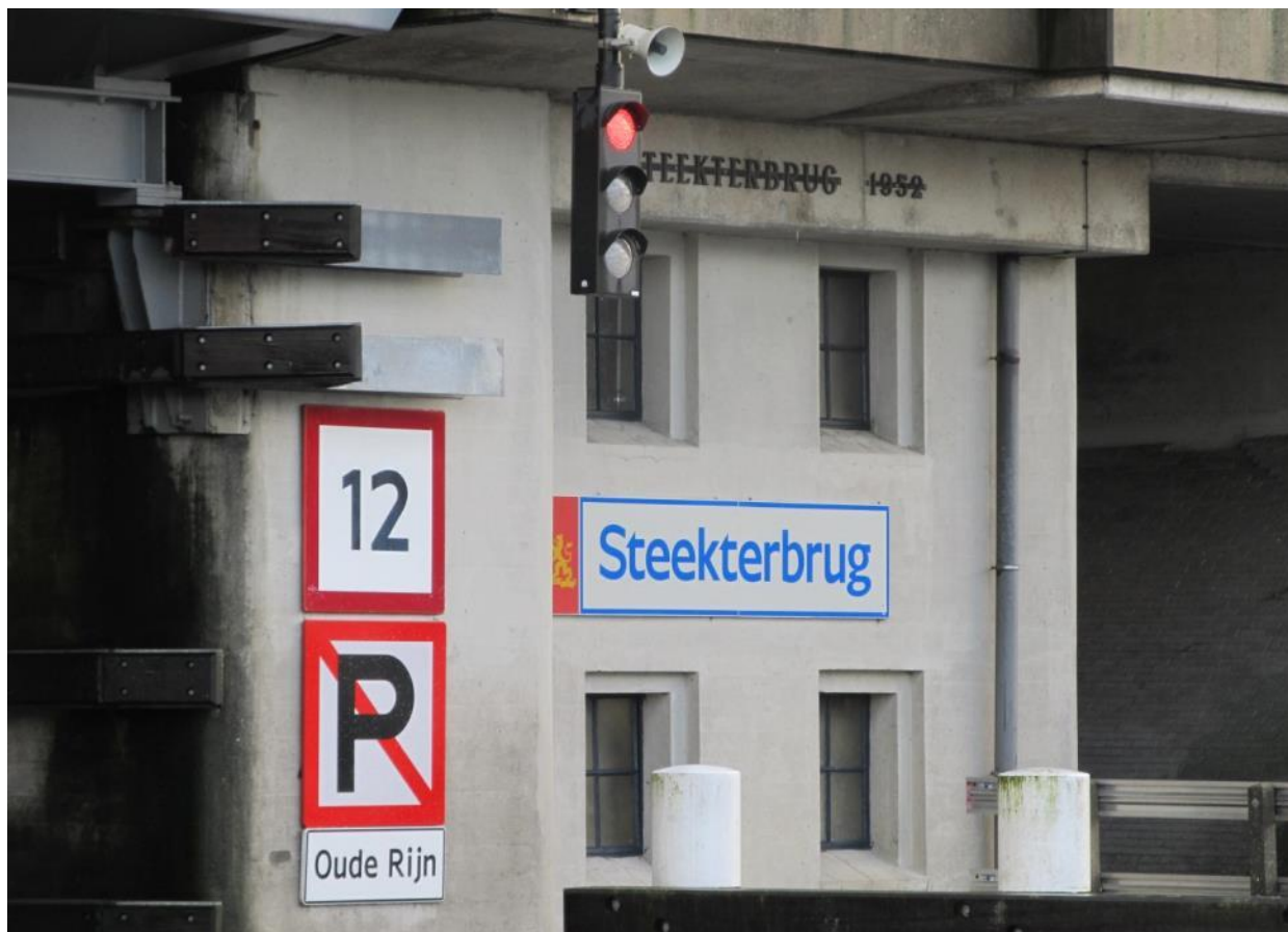
Figuur 1: Steekterbrug Alphen aan de Rijn
