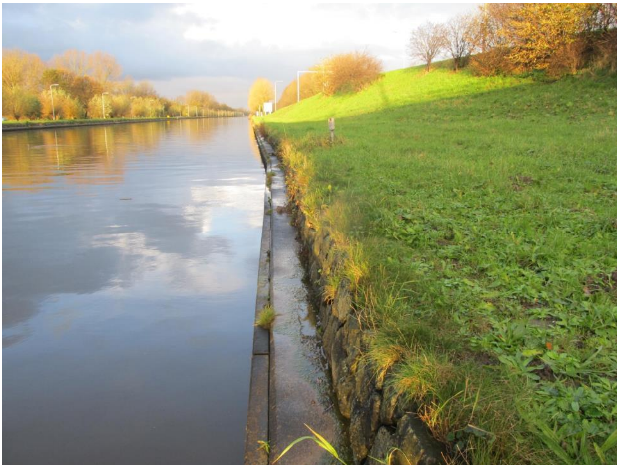
Figuur 5: oever Aarkanaal en berm N207
