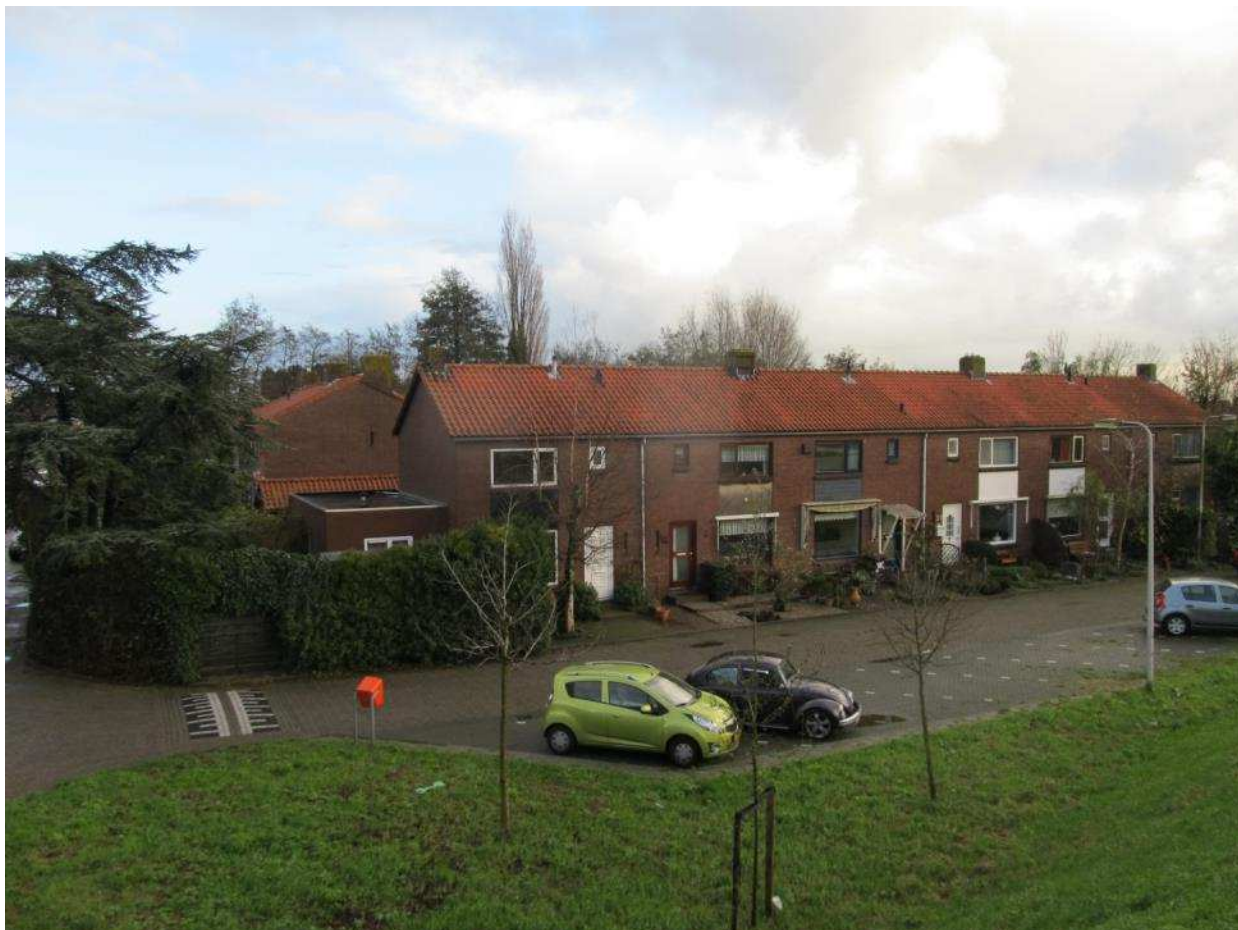
Figuur 16: plangebied K: rijtjeshuizen met pannendaken, waarin geen huismussen kunnen broeden.
