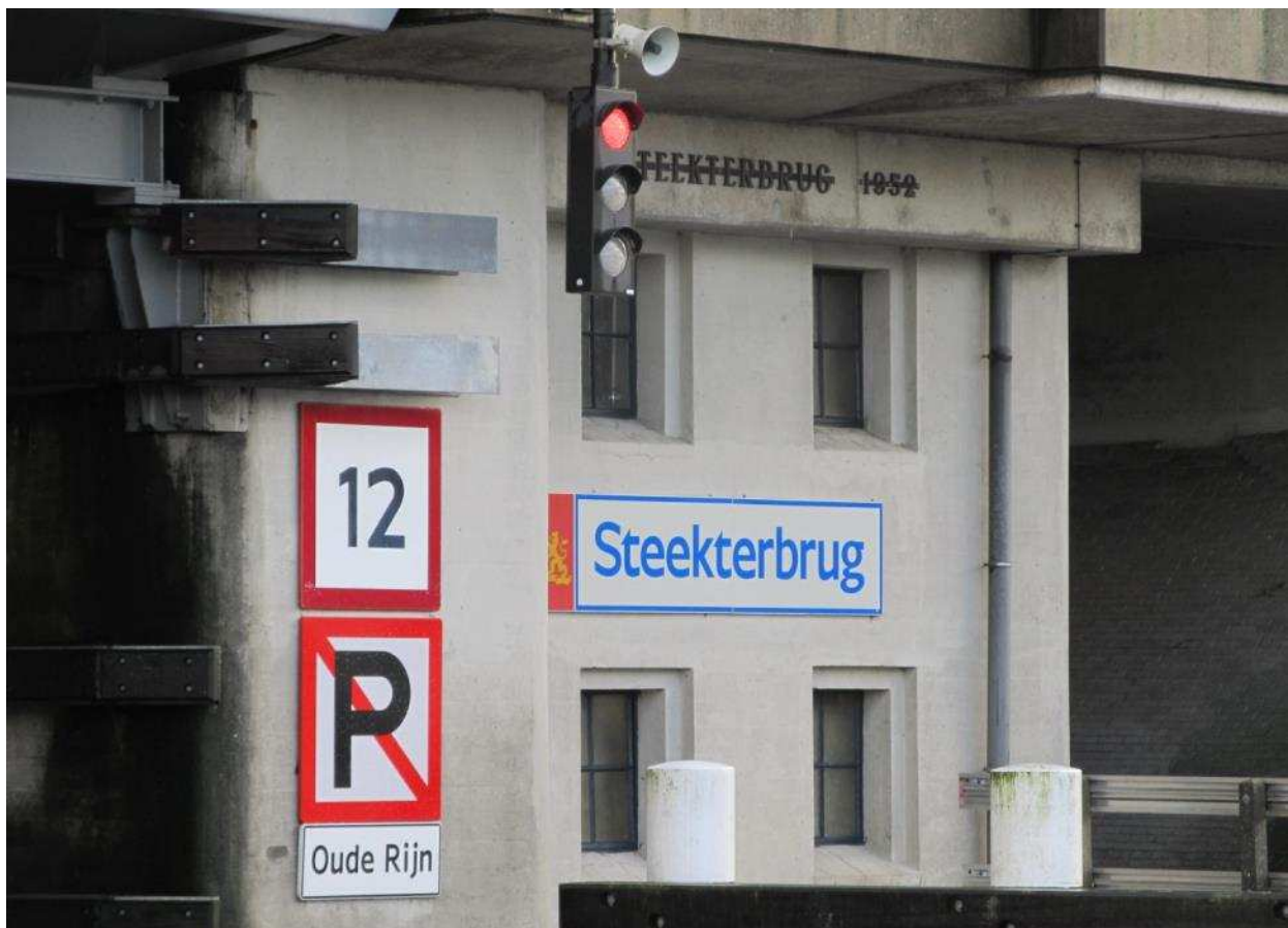
Figuur 1: Steekterbrug Alphen aan de Rijn
