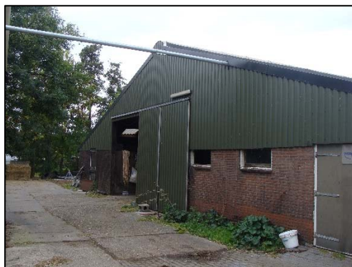
Foto 1. Te slopen melkveestal
