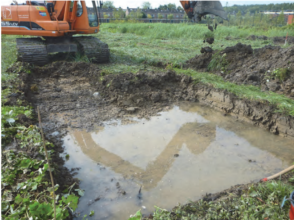
Fig. 4.2: Aanleg van het vlak in wp3.
