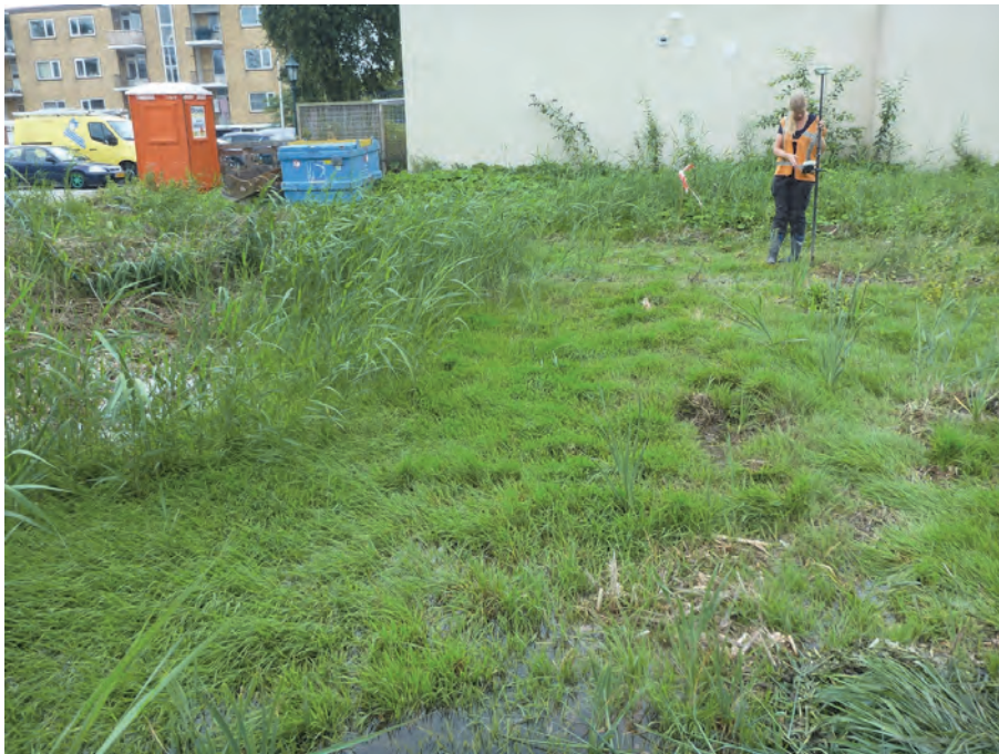
Fig. 4.4: Uitzetten van de werkputten met de GPS. Op voorgrond en links op foto is te zien hoe nat het terrein plaatselijk was.
