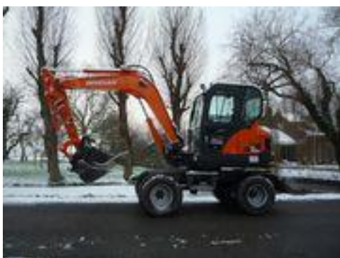
Grondwerk vindt ook in de winterperiode plaats
