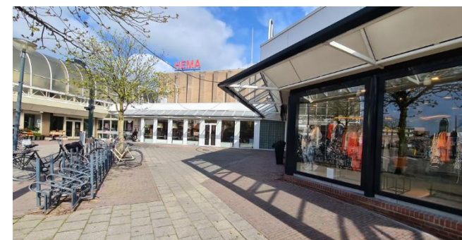
Figuur 6: Te slopen gedeelte bij de zuidelijke ingang van winkelcentrum de Aarhof gezien vanaf Van Boetzelaerstraat
