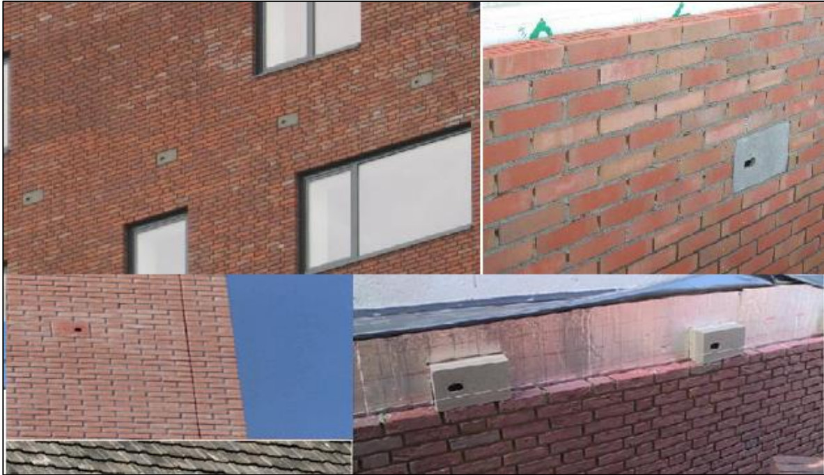
Afbeelding 9: Vrijwel onzichtbare inbouw van vleermuisstenen en technische informatie over de plaatsing daarvan
