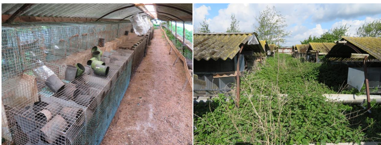
Afbeelding 5: Schuren van maximaal 2,1 meter hoog. De schuren zijn aan de zijkanten open en hebben een golfplaten dak.
