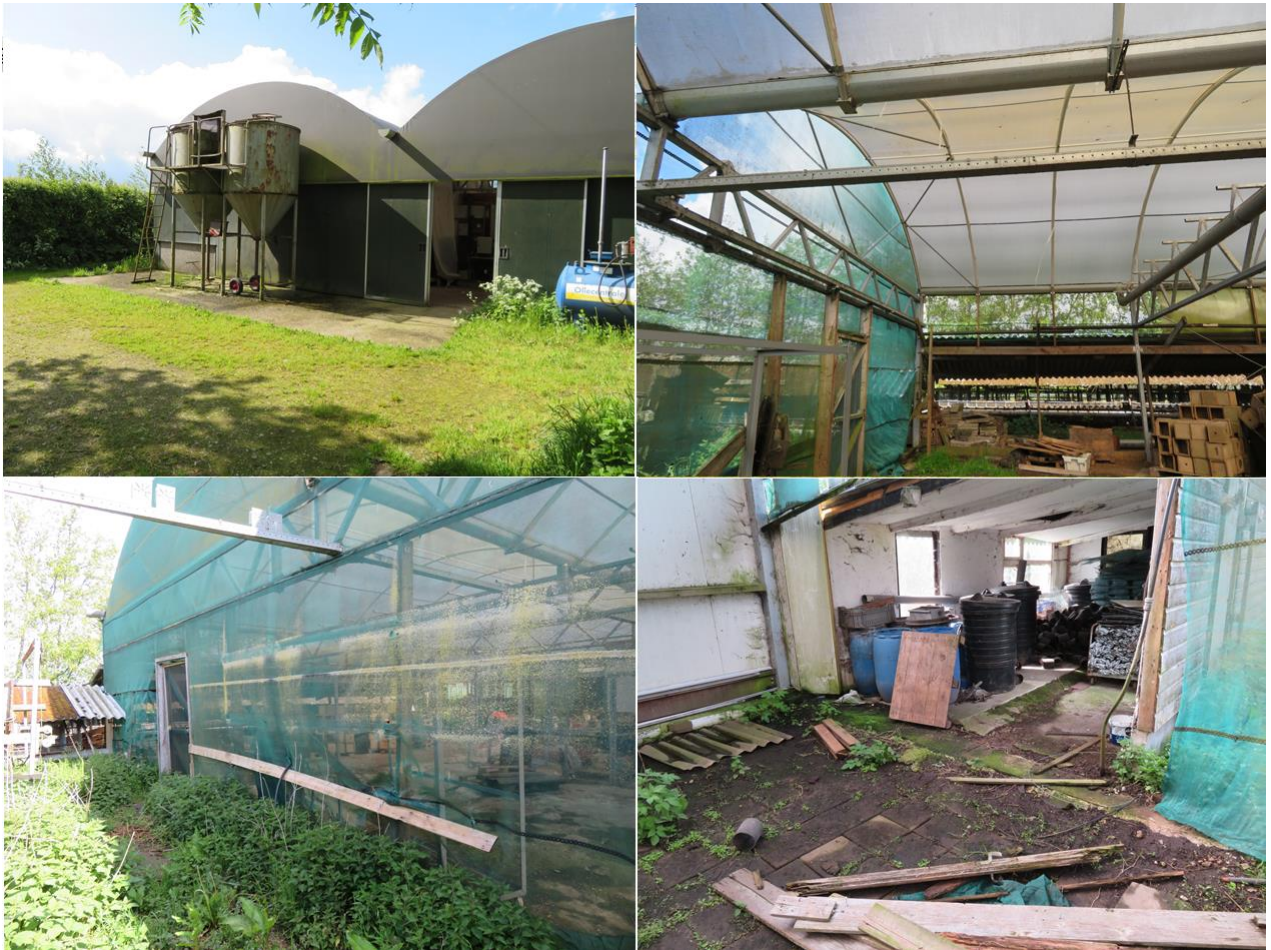
Afbeelding 3: Loods voor opslag
