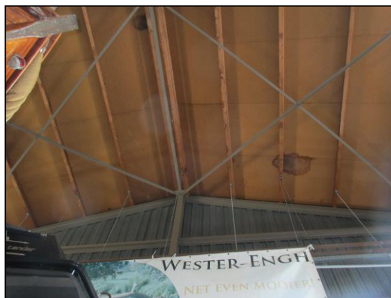
Foto 4: Plafond van de loods in plangebied
