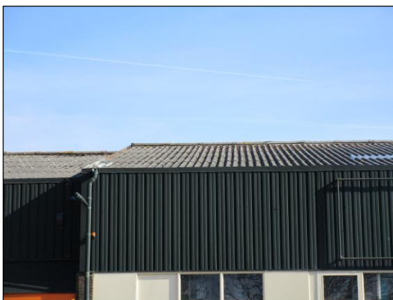
Foto 3: Dak van de loods in plangebied
