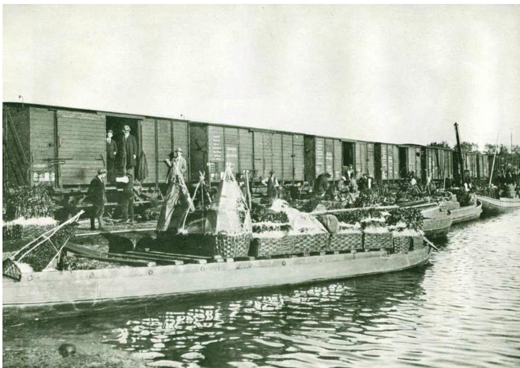
Figuur 30: Ongedateerde foto van de spoorhaven, vermoedelijk uit het einde van de 19 e eeuw (Onbekende Fotograaf 1900).
