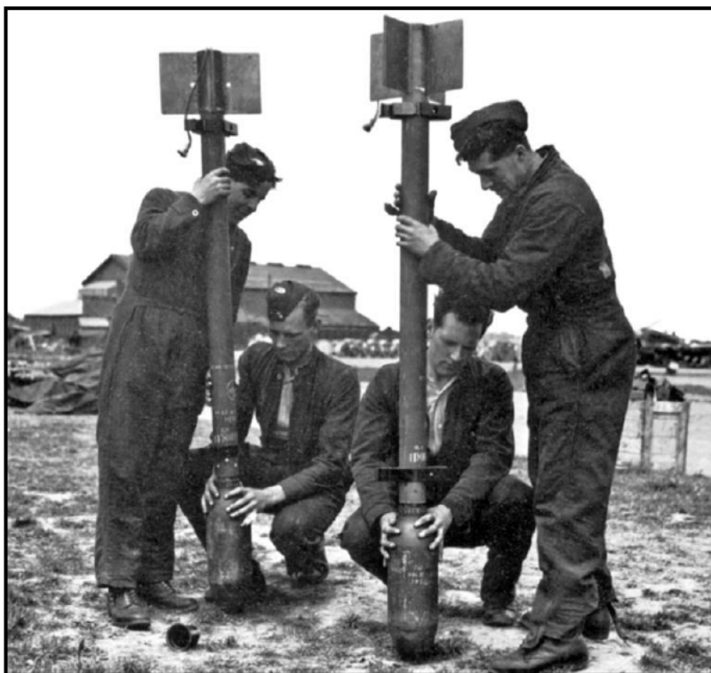
Figuur 17. Voorbeeld van het samenstellen van de 3 inch raketmotor met een gevechtsslading SAP-HE van 60 lb.
