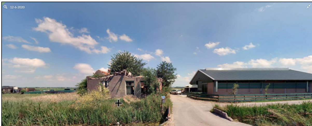
• Figuur 2.8: Aanzichtfoto uit 2020 tussen de woning Ridderbuurt 83 (Cornelishoeve) en de schapenstal (bron foto: streetsmartcyclomedia)
