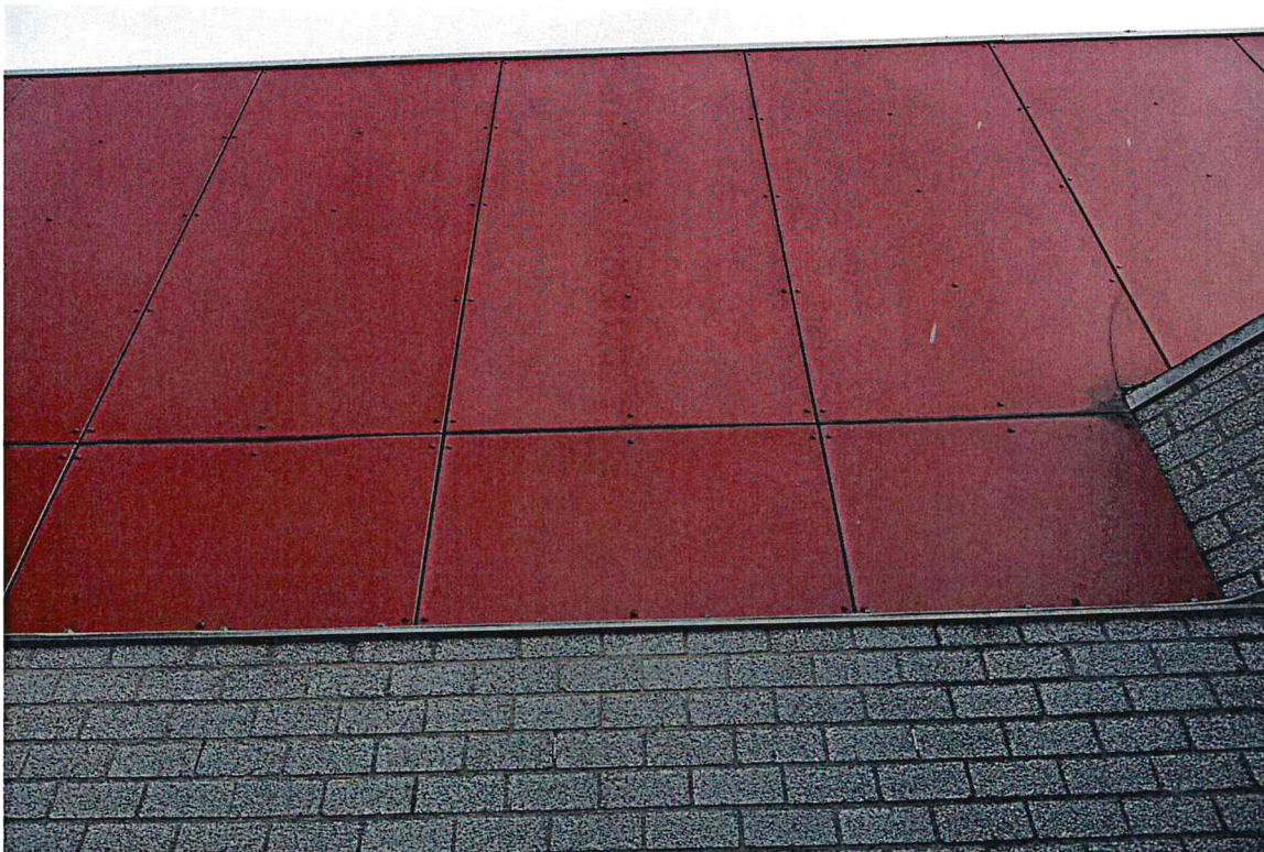
Foto 5 op diverse plekken is de ruimte achter de beplating toegankelijk
