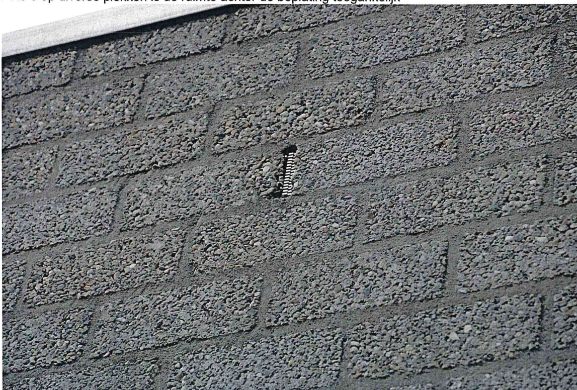
Foto 6 de meeste open stootvoegen zijn voorzien van bijenbekjes
