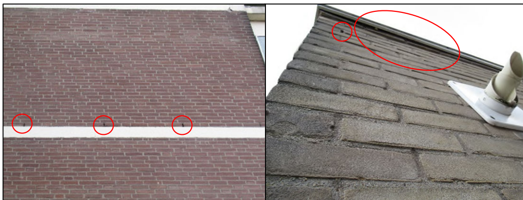
Afbeelding 4.1 Potentiële toegangsmogelijkheden voor vleermuizen in het flatgebouw (links) en bungalow (rechts) (Primum, 2020).
