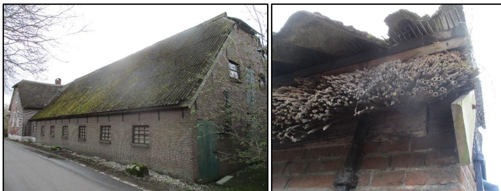
Figuur 4 Gebouw B (links) en een close-up van het dak (rechts).
