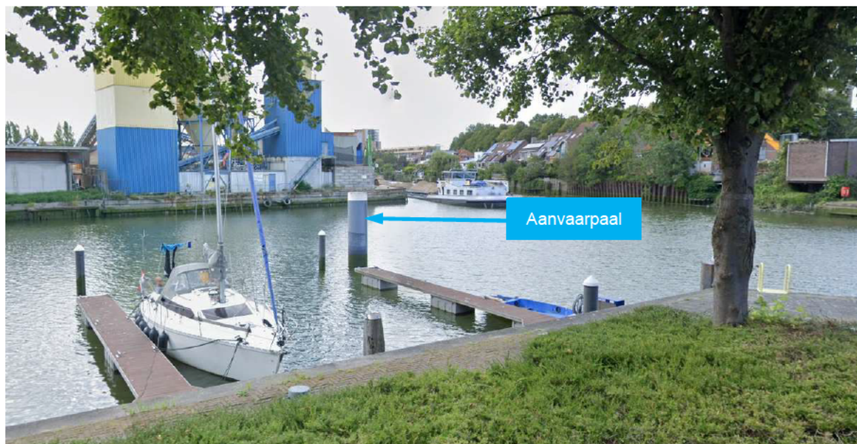
Figuur 10: Voorbeeld van een aanvaarpaal gelegen in een jachthaven van Maassluis
