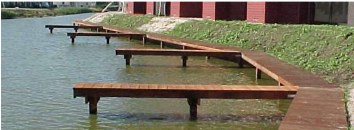
Figuur 14: Voorbeeld van een vaste steiger
