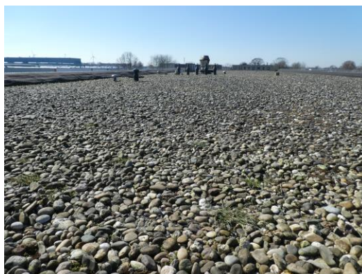
Figuur 17 Dak gebouw B
