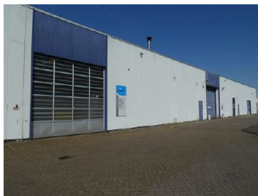
Figuur 7 Pand C achterzijde
