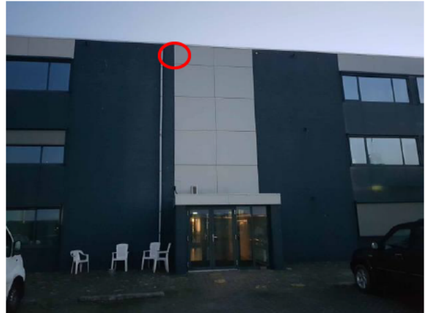
Figuur 7: Locatie paarverblijf pand B, achterzijde
