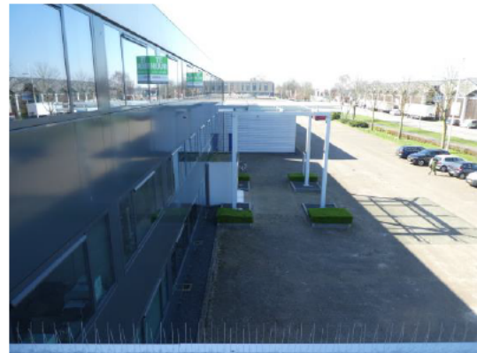
Figuur 19 Trespa platen voorzijde gebouw B
