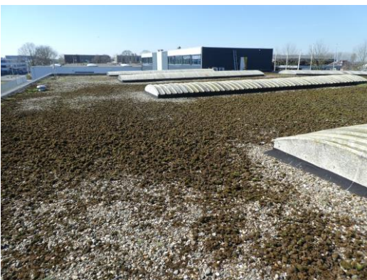
Figuur 18 Dak gebouw A
