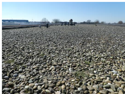
Figuur 17 Dak gebouw B
