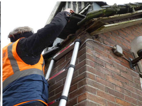
Figuur 12 Onderzoek dakpannen
