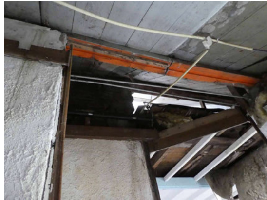
Figuur 15 Detail dak binnenzijde woning (opening naar buitenlucht)
