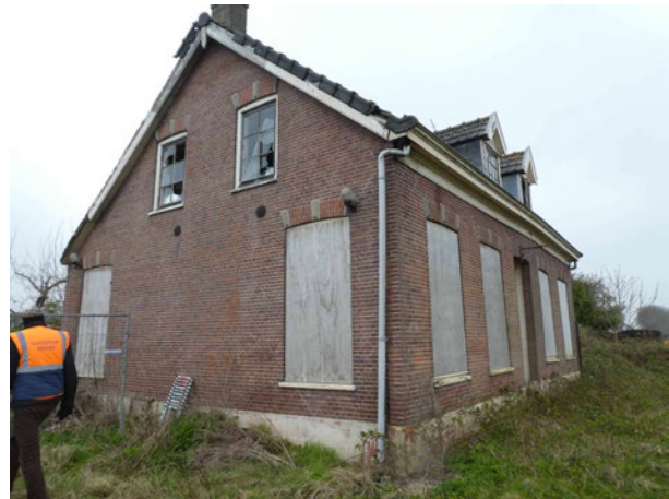
Figuur 17 Zijgevel woning
