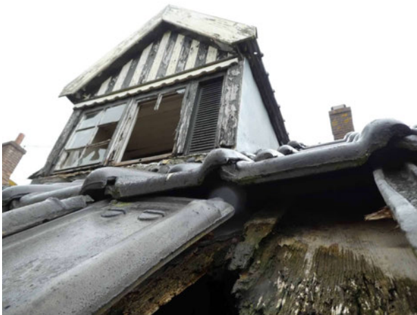
Figuur 18 Detail dakpannen
