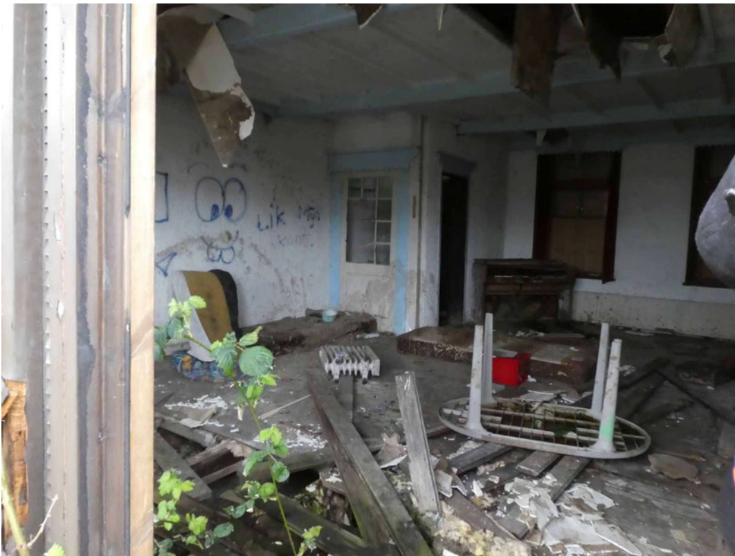
Figuur 5 Indruk binnenzijde woning
