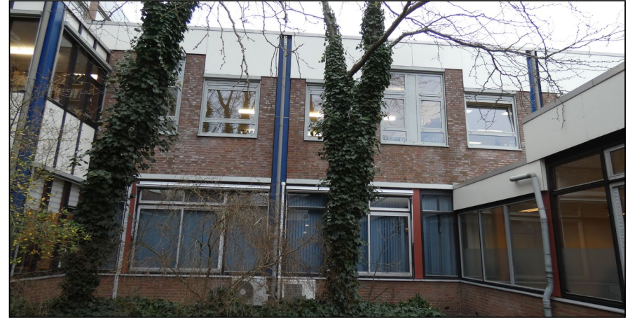
Figuur: in een binnentuin van de school staan 3 klimopbomen, waardoor boomholtes niet uitgesloten kunnen worden. Ook zijn er open stootvoegen in de gevels aanwezig. Vleermuizen kunnen aanwezig zijn.
