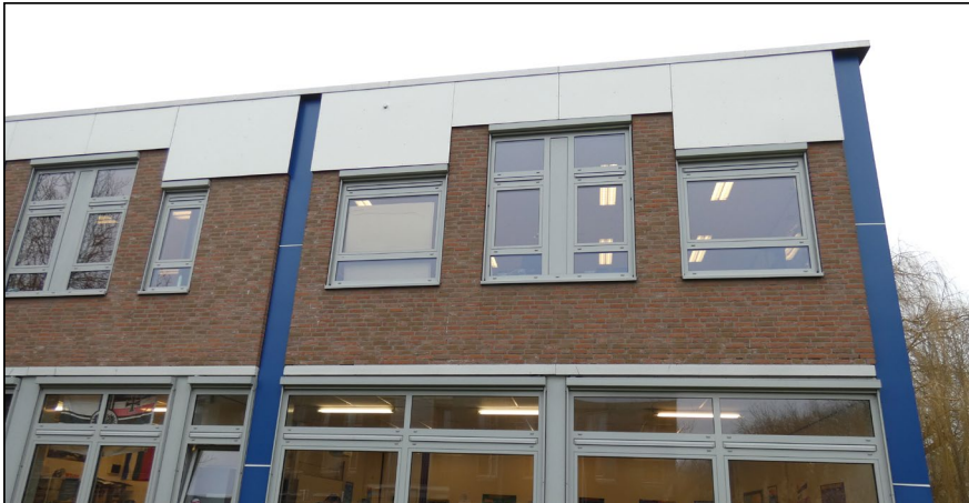
Figuur: op de gevels van het Scala Collega zijn platen aangebracht. Achter deze platen is geen ruimte aanwezig voor vleermuizen.
