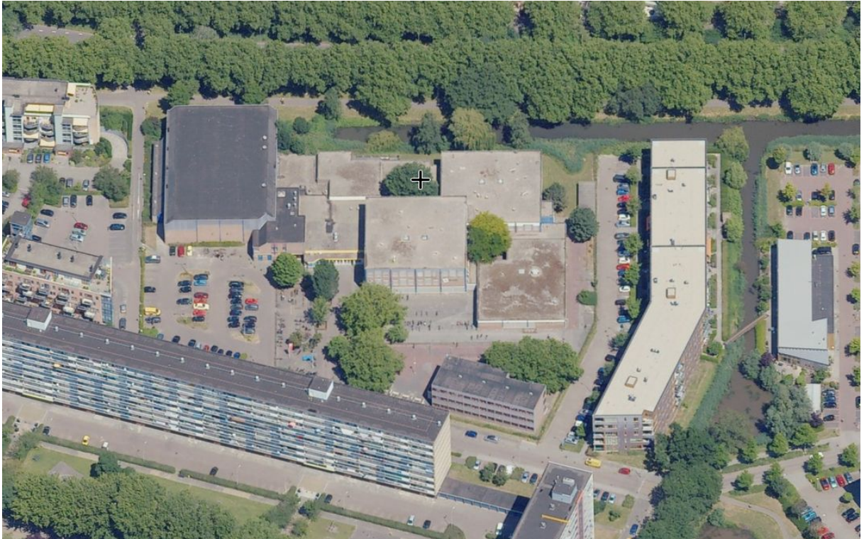
Figuur 2: Huidige situatie (Cyclomedia)
