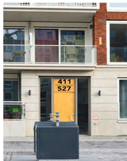
onduidelijke hoofdentree Holland Park, Diemen, Soeters
