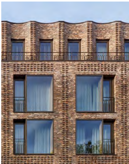
gelaagde gevelopbouw Pillows, Amsterdam, Office Winhov
