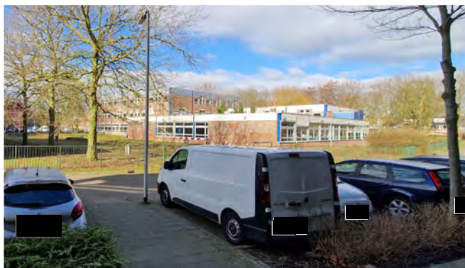
2 zicht vanuit Amethyststraat naar de projectlocatie
