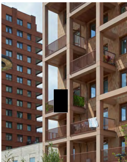
balkondetailering + gevel in harmonie Gascoigne West, Londen, White Arkitekter
