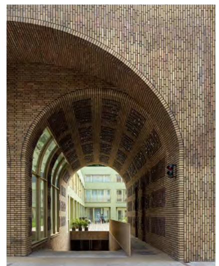
geen onderdoorgangen ✗ Spaandammerhart, A'dam, Korthliens ML_A
