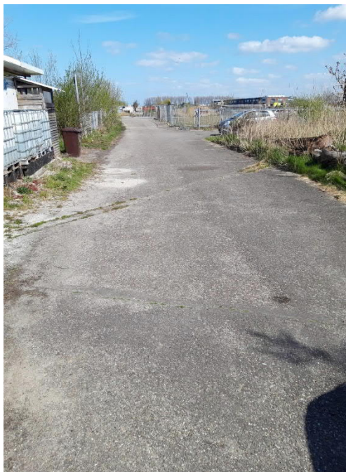
foto 29: asfalt zuidelijk deel
