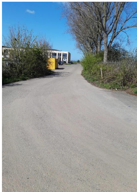
foto 30: asfalt zuidelijk deel
