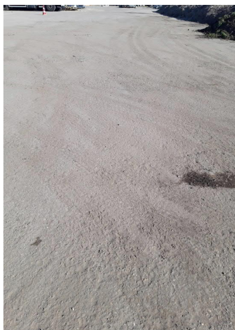
foto 16: indruk oudste asfaltverharding
