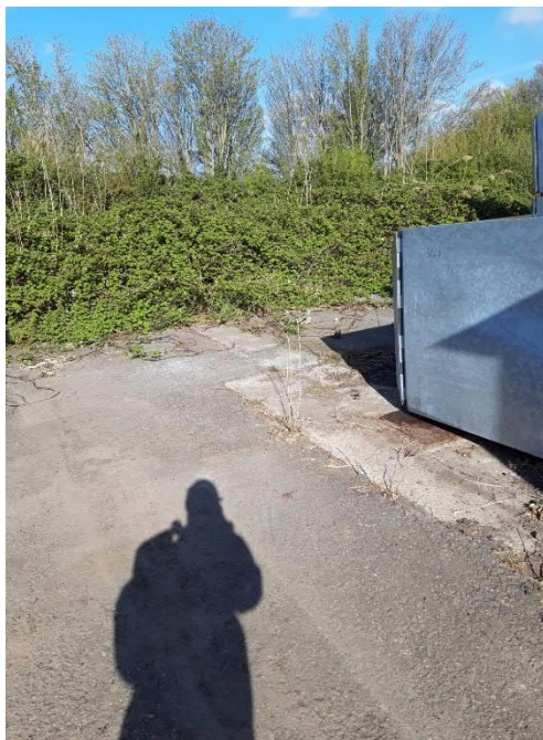
foto 7: voormalige opstallen / betonbalk / begroeiing
