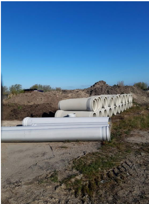
foto 3: gronddepot ter plaatse van contour PAK > I
