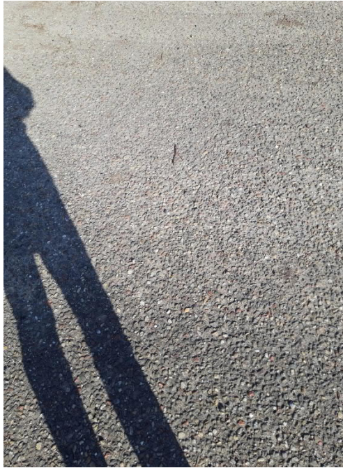
foto 17: indruk oudste asfaltverharding
