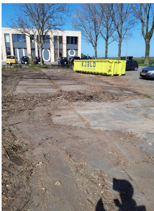
foto 23: parkeerterrein met stelconplaten
