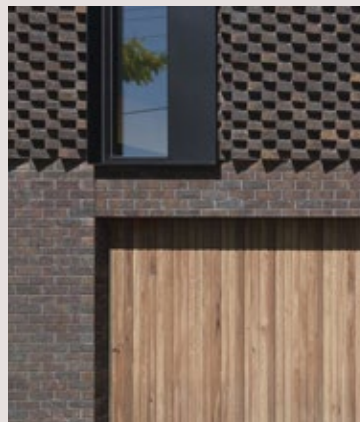
secundair materiaal in de gevel
