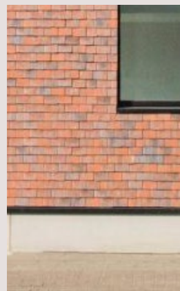
gebruik van secundaire materialen in de gevel
