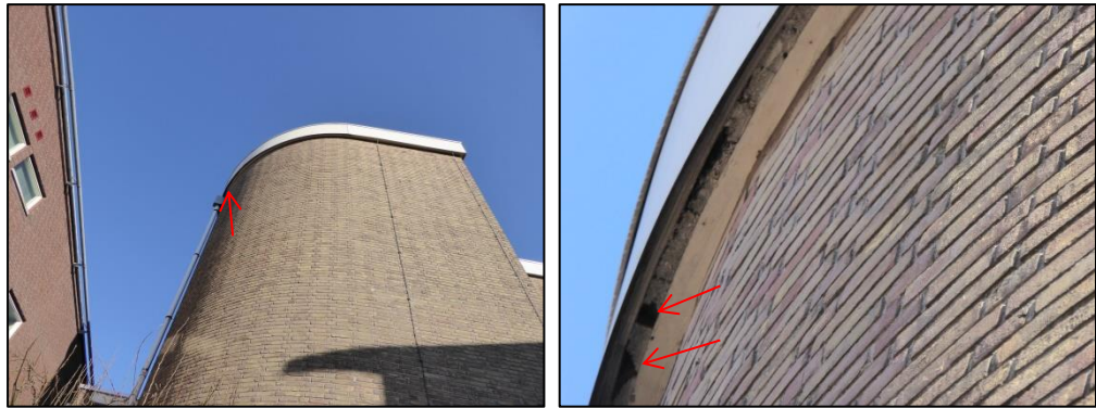
Kieren in de dakrand in het zuiden van het plangebied (aangeduid met een rode pijl).
