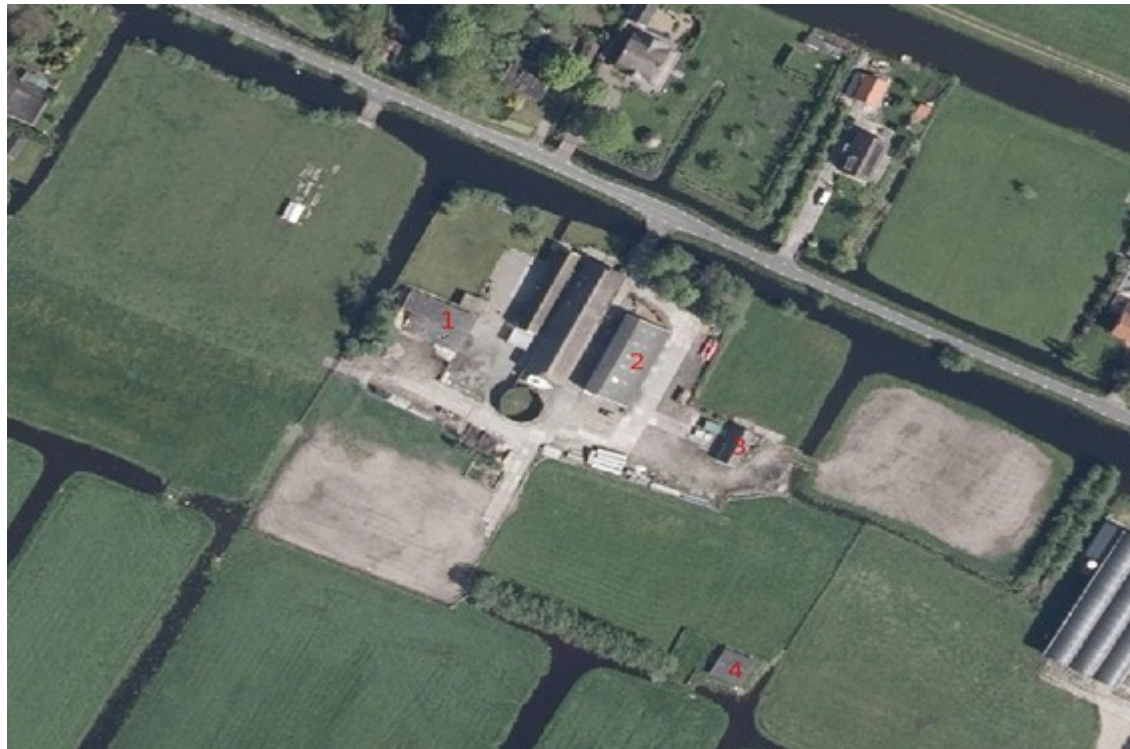
Figuur 4: Overzicht van de te slopen opstallen 1 t/m 4.
