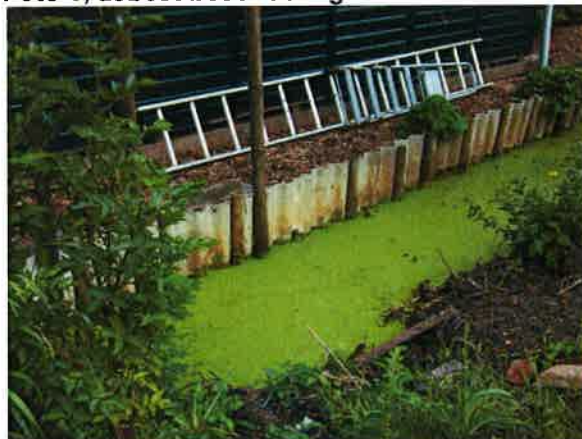
Foto 5, asbest beschoeiing
