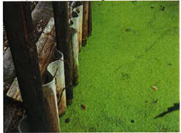
Foto 6, asbest beschoeiing
