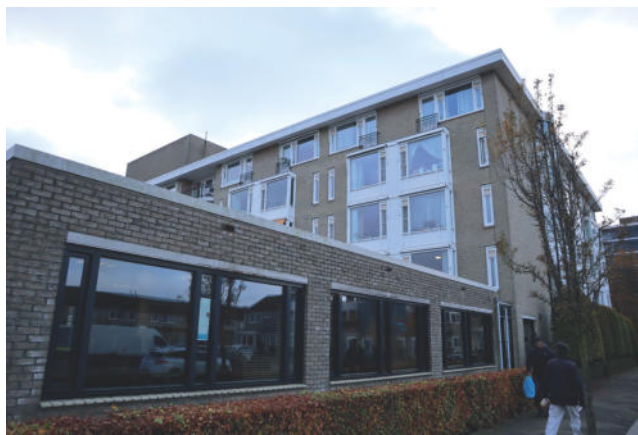
Architectengroep NSL, uitbreiding aan de oostzijde, 2004
