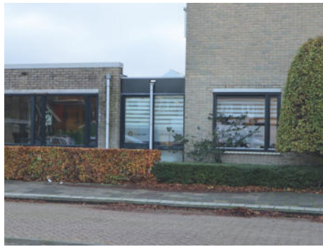
Noordgevel met de uitbreiding uit 2004
