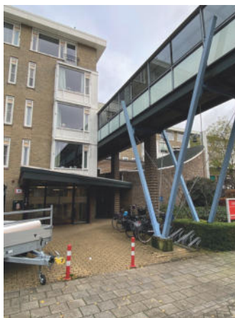
Hoofdingang met brug boven de kapel
