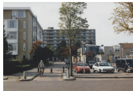
Zicht op flat Statenhoek met links zorgcentrum Saenden en rechts de geschakelde woningen uit 1990 (Foto [REDACTED] / Archief Zaanstad)
