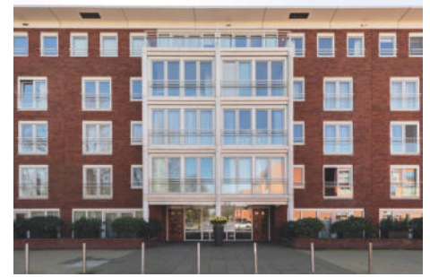
NSL architecten, woongebouw Kalfjeslaan, Amsterdam, 2002-
