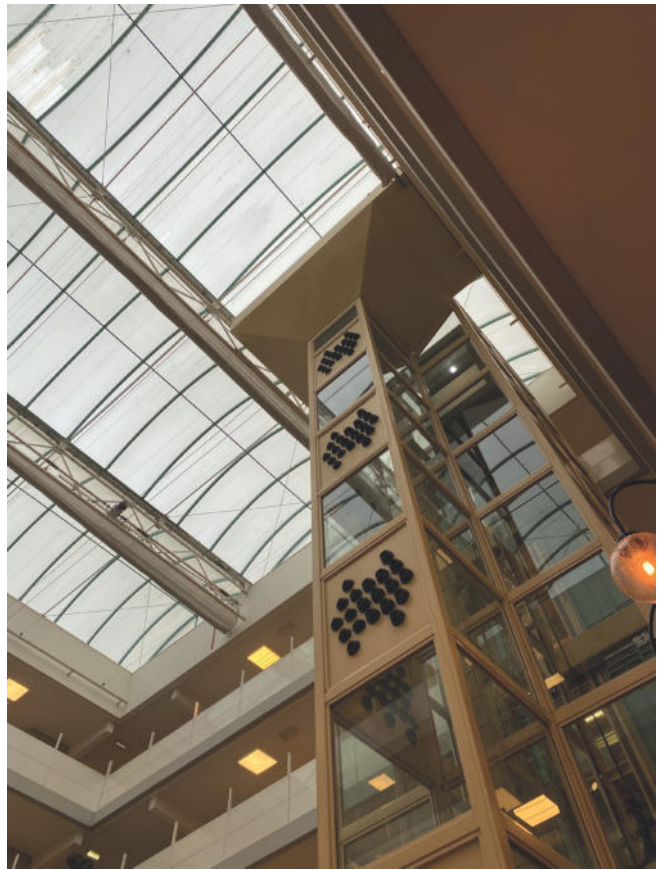
Overkapping en lift in de binnentuin
