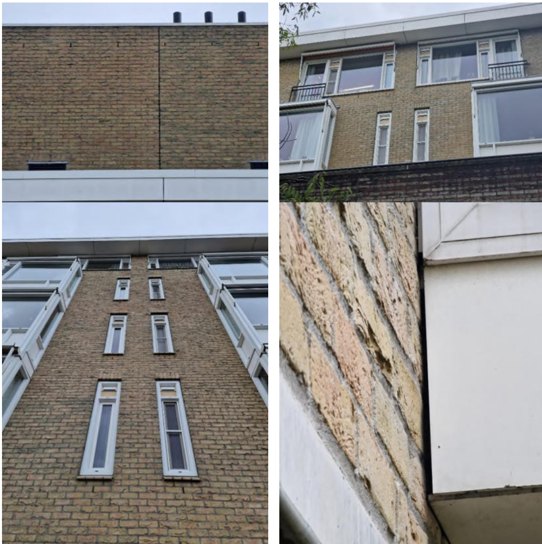
Figuur 3.1 Mogelijke invliegopeningen voor vleermuizen in de vorm van open stootvoegen en ruimte tussen een pui en de muur
