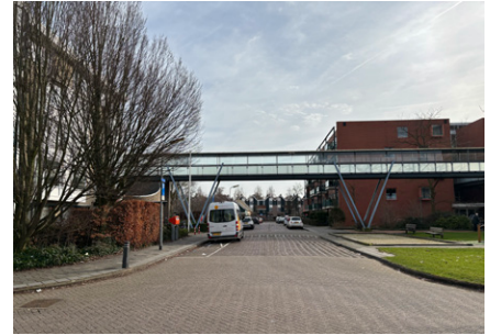
Luchtbrug verbinding met het Fluytschip
