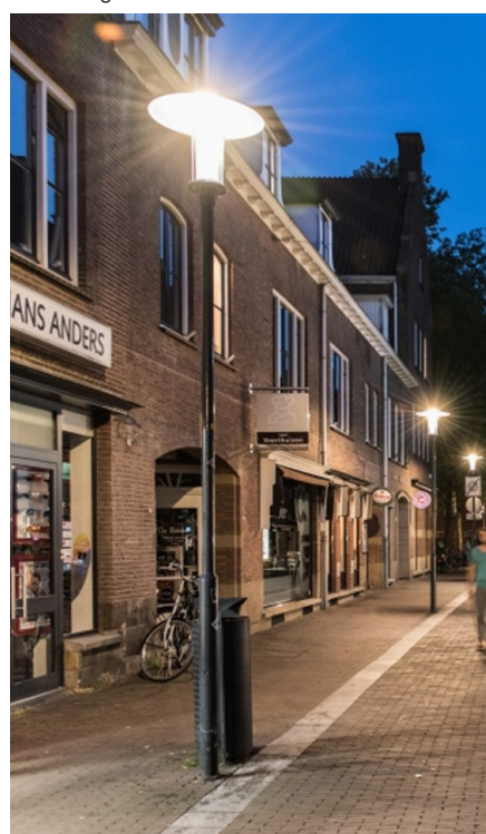
groene as conform Inverdan, type mast: paaltop mast: conisch naadloos getrokken hoogte: 3.5 m armatuur: Schreder Starlight LED
