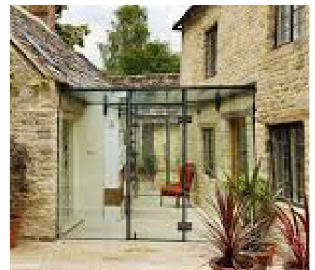
Voorbeeld van een transparante glazen uitbouw resp. verbinding tussen de twee gebouwen
