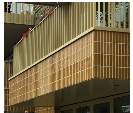
Material keuze en kleuren zijn op elkaar afgestemd
