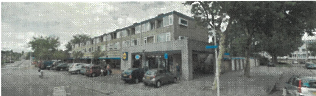
Huidige situatie Lidl Cor Bruijnweg 64 te Wormerveer (google maps, 2024)
