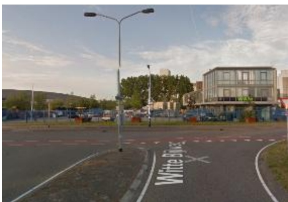
Figuur 10 Voormalige bebouwing en verkeerssituatie Vlasblomweg 22 (google maps, 2015)
