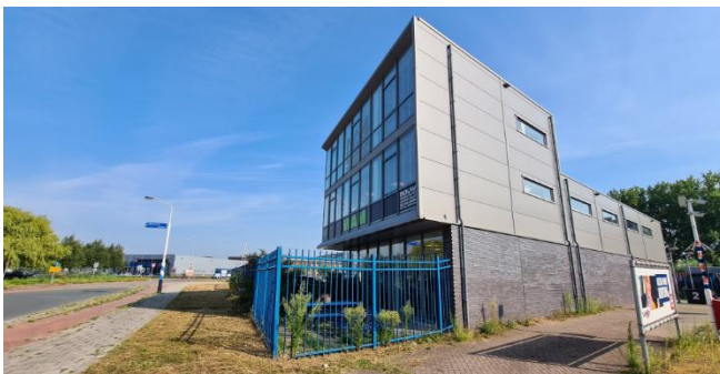
Figuur 7: Zuidzijde gebouw vanaf straat
