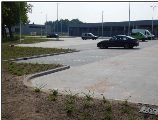
Degelijke ontluuchtingsconstructie met kolkkop
