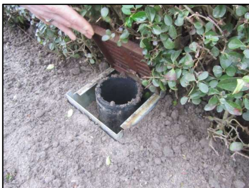
Eenvoudige ontluchting van roestvaststaal 17x17cm
