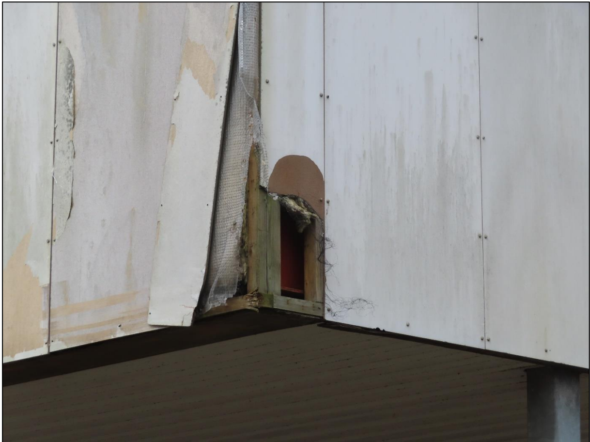
Figuur 2.4. Een ruimte achter gevelbetimmering van een gebouw binnen het plangebied.
