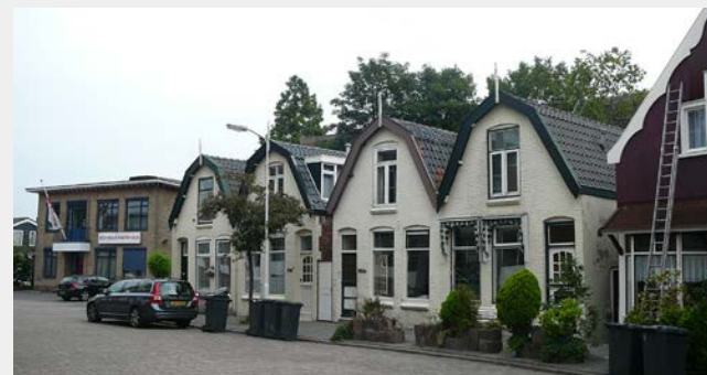
Bestaande woningen aan de Oostzijde
