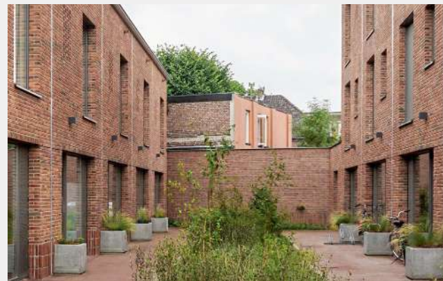
Tijdelijke erfafscheiding ten zuiden van het hofje, volwaardig onderdeel van de architectuur
