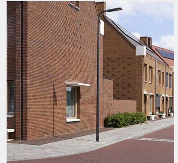
Stenen tuinmuren - worden gebruikt om de bouwblokken te benadrukken en zijn onderdeel van de architectuur.
