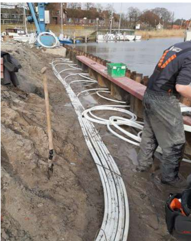
Damwanden met leidingenwerk
