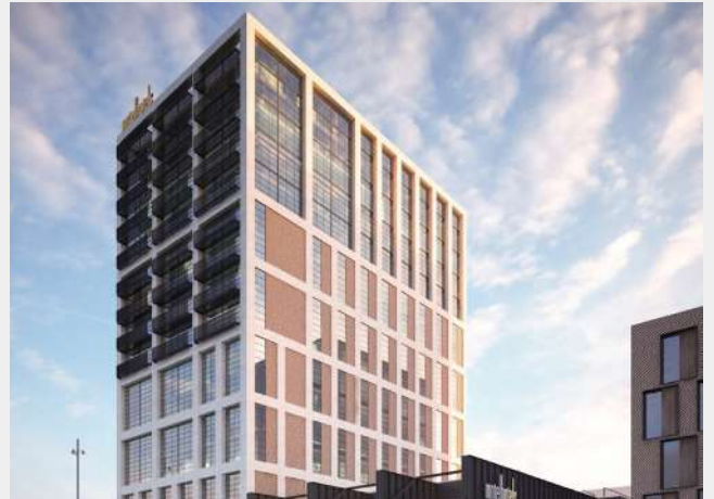
Zichtbaarframe met metselwerk (Oostenburg, Amsterdam)
