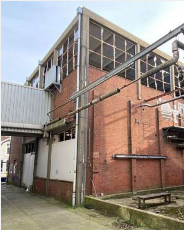
Noord- en westgevel an de zeepziederij
