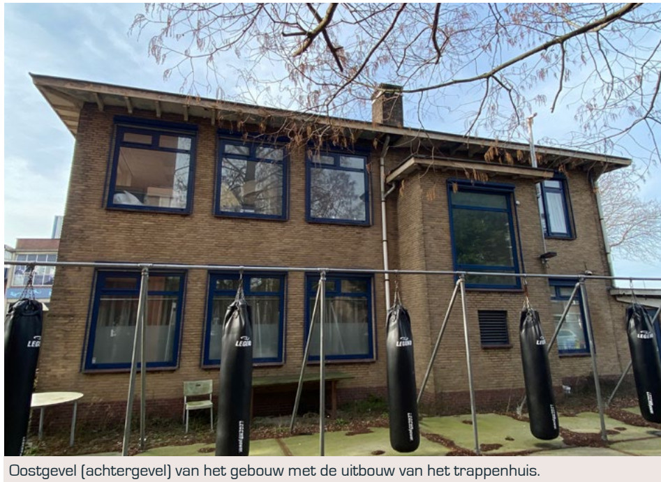
Oostgevel (achtergevel) van het gebouw met de uitbouw van het trappenhuis.
