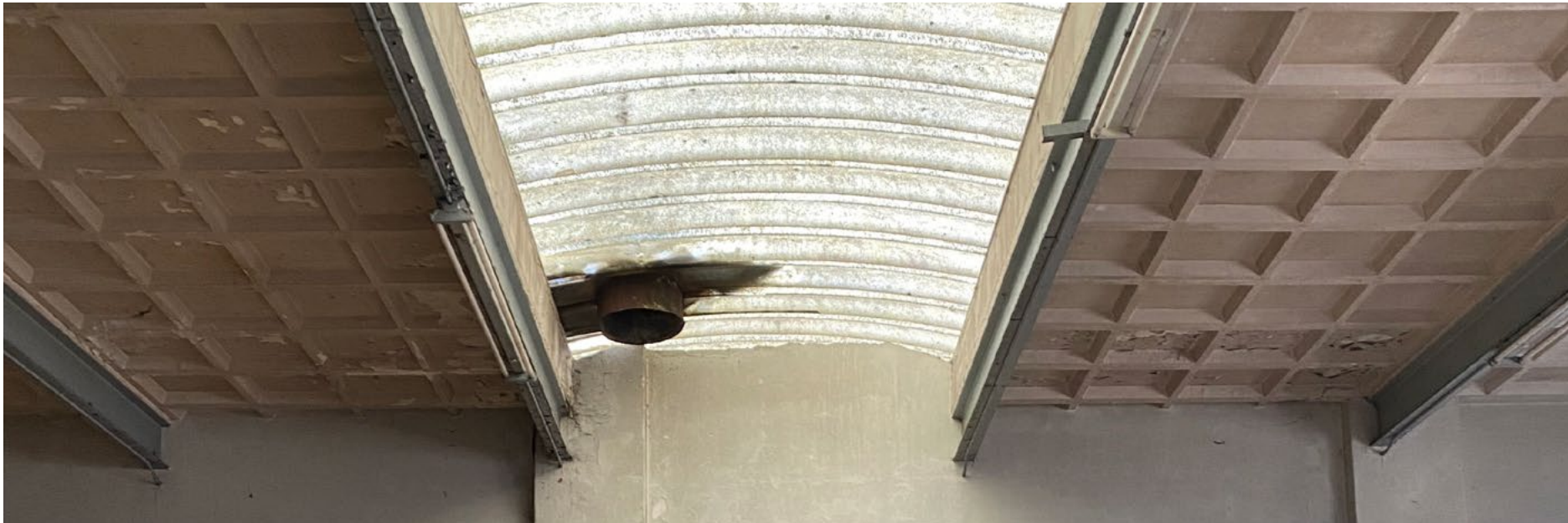
De lichtstraat in het dak van het magazijn loopt door over de tussenwand van de gang.
