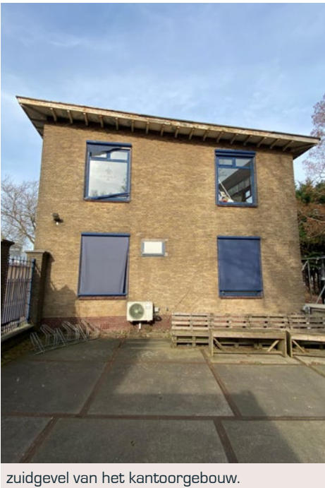
zuidgevel van het kantoorgebouw.
