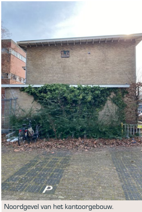
Noordgevel van het kantoorgebouw.
