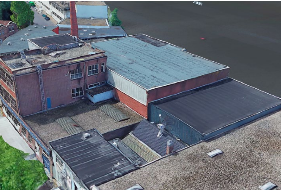
Noord - en oostgevel van het magazijn met hergebruikte geveldelen [Google Earth].
