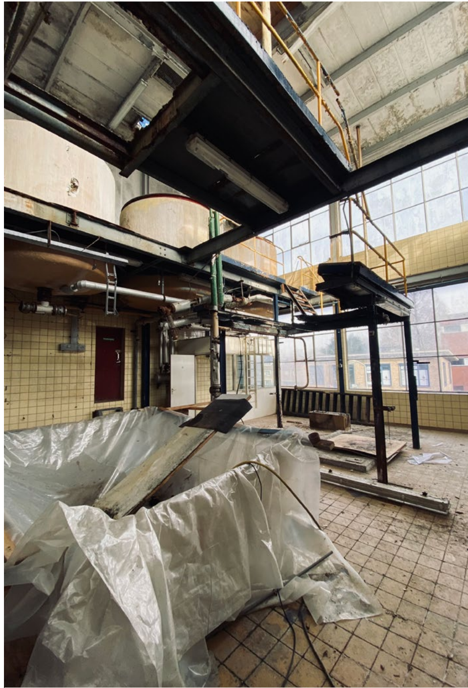
Restanten van de vacuüm droog - koelinstallatie in de dubbelhoge ruimte.
