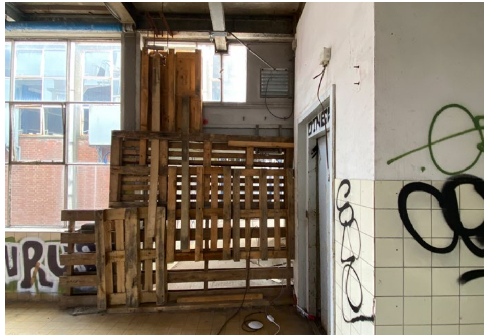
Lift en gebarricadeerde doorgang naar de lichtbrug in de zuidgevel van de uitbreiding.
