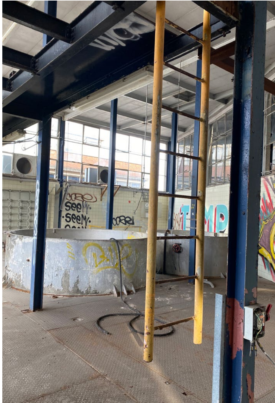
Traanplaten vloer en lichtgele tegellambrisering.
