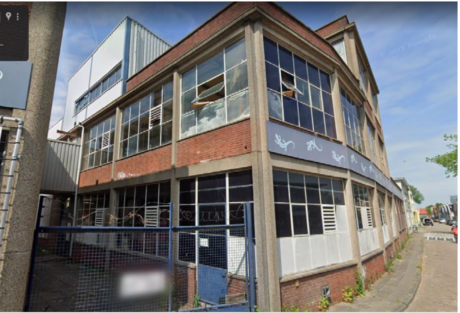
Zuid - gevel van de uitbreiding van het “Mazzoni - gebouw”.
