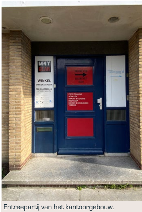
Entreepartij van het kantoorgebouw.
