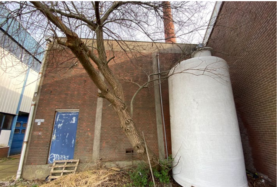
Westgevel (zaanzijde) van het ketelhuis met toegangsdeur en brandstoftank.
