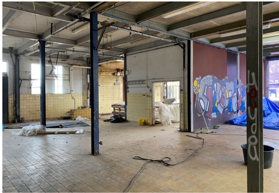
De eerste verdieping met zicht op de ruimte van de Mazzoni - installatie.
