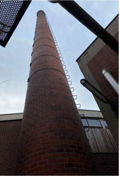
Schacht van de fabrieksschoorsteen.
