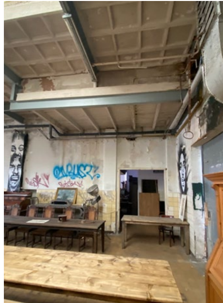
Verlaagde constructie van dakopbouwje in de zuid - west hoek van het magazijn.
