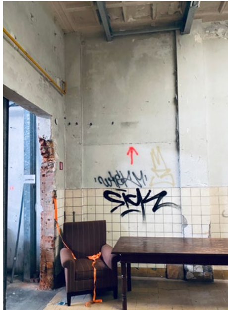
Doorgang tussen gang en magazijn; oude geveldelen van de zeepfabriek.
