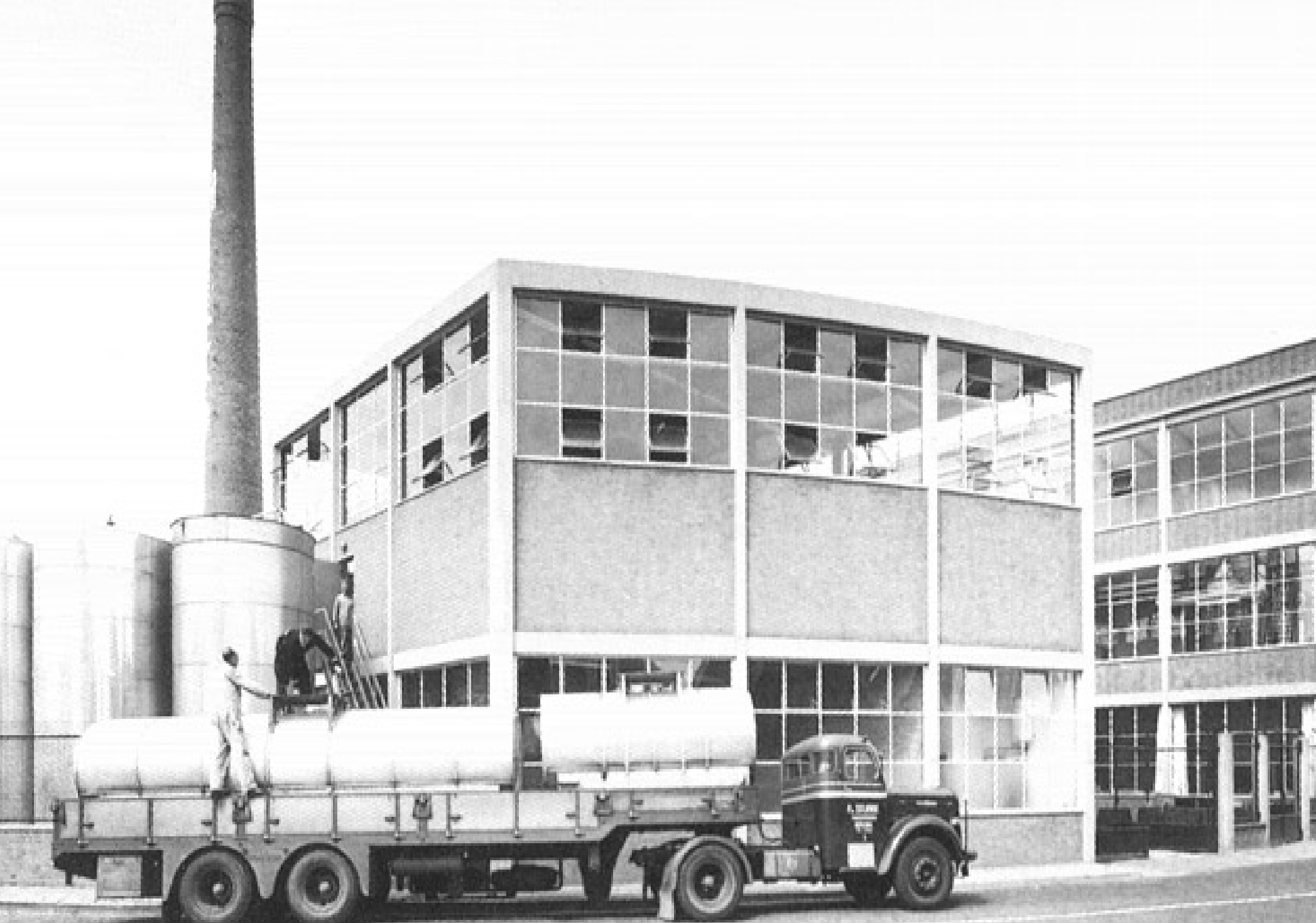
De nieuwe zeepziederij aan de Oostzijde met links de opgestelde vettanks. Achter de vrachtwagen is de toegang tot het gebouw zichtbaar, via de stalen trap langs de zuidgevel. [GAZ].
