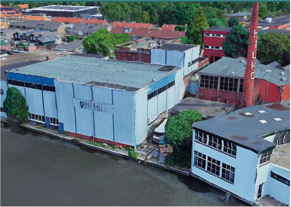
West - en zuidgevel van het magazijn (links) en de werkplaats (rechts) [Google Earth].
