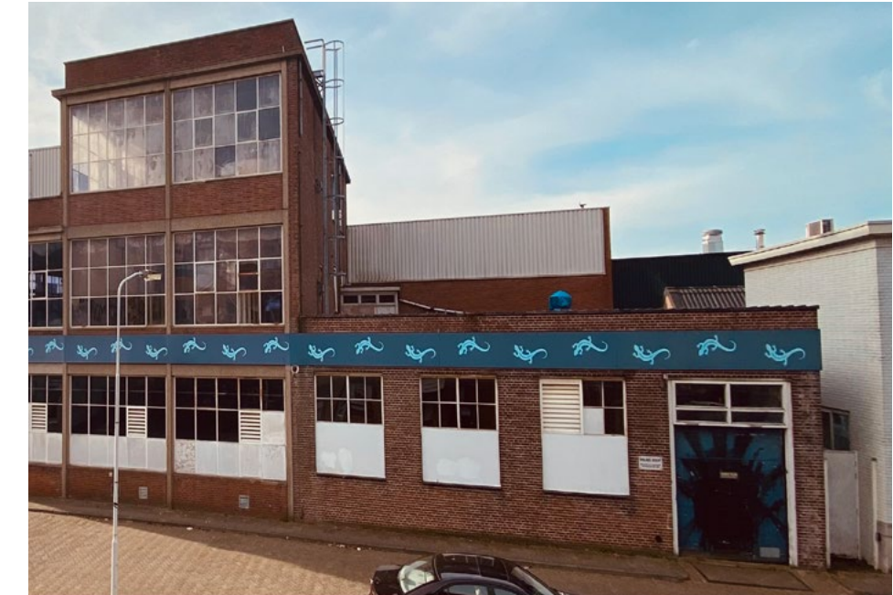
De voorgevel van het magazijn aan de Oostzijde.
