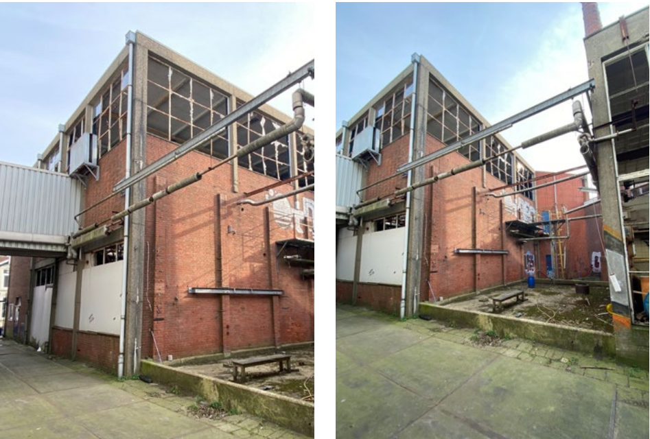
Noord - en westgevel van de zeepziederij.
