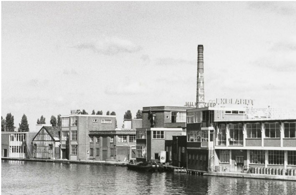
Het complex van de HILKO - zeepfabriek met fabrieksschoorsteen aan de Oostzijde in Zaandam, ca. 1962 [GAZ].
