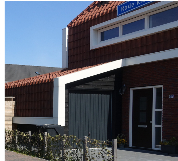
ENTREE MET BERGINGEN AAN DE STRAAT ONDER DE KAP
